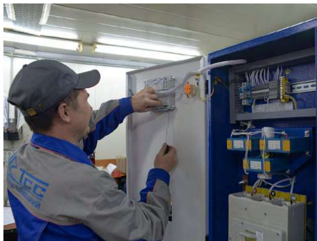
СБОРКА ЩИТОВ УПРАВЛЕНИЯ
