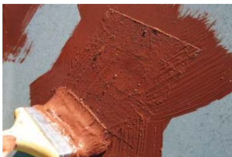
4. Покрываем ткань мастикой Elastomeric-911
