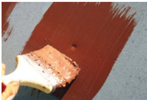
2. Покрываем мастикой Elastomeric-911
