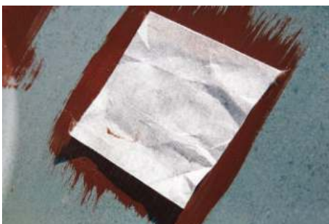
3. Армируем ткань "Elastomeric Fabric"
