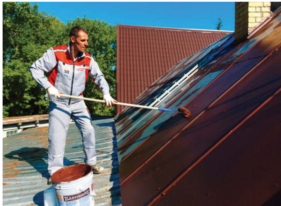
5. Покрываем всю площадь в 2 слоя
